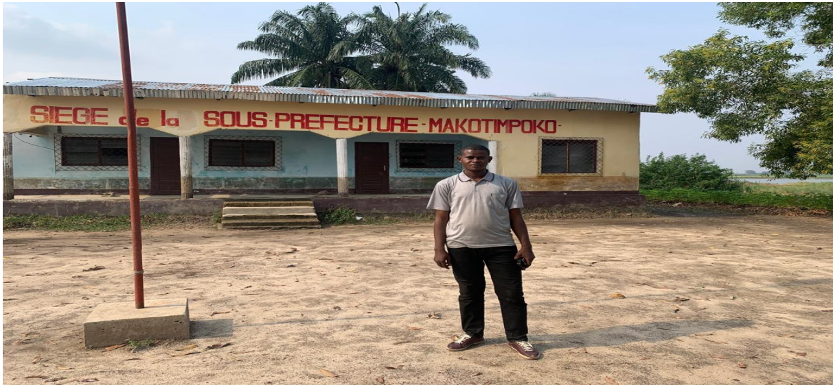
Ici bâtiment abritant le centre d'état civil de Makotipoko après les inondations
