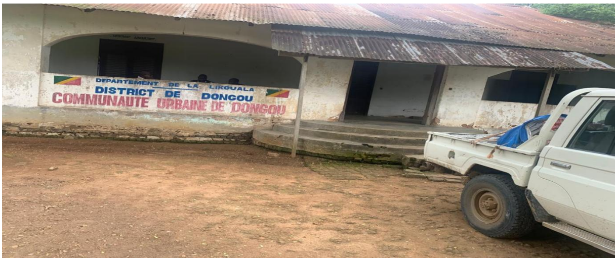
Centre d'état civil de Dongou dans un état de délabrement
